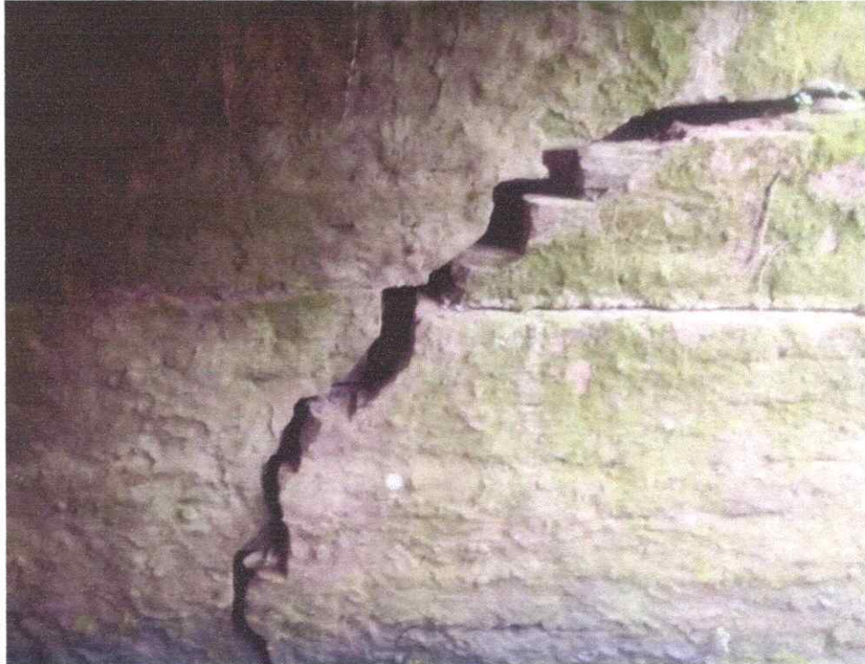
Figura 2 – Fissuras à 45° no elemento estrutural
